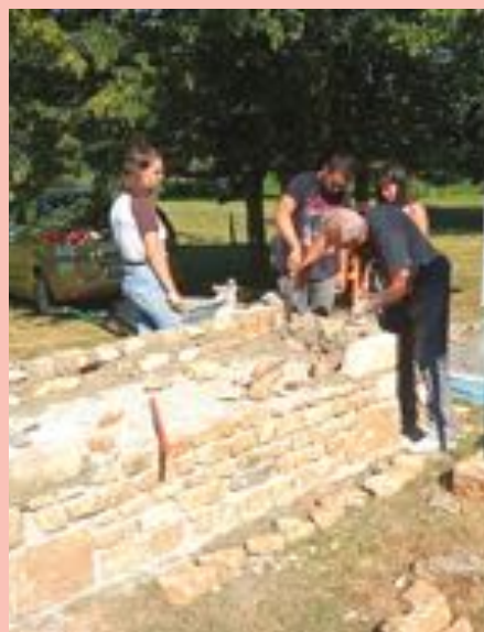
CONSTRUCTION DU BARBECUE DE L'ÉTANG (DR)
